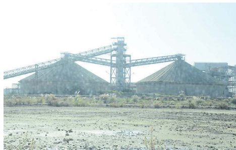
Una delle aree interne del Prolchimico soggetta a risanamento
