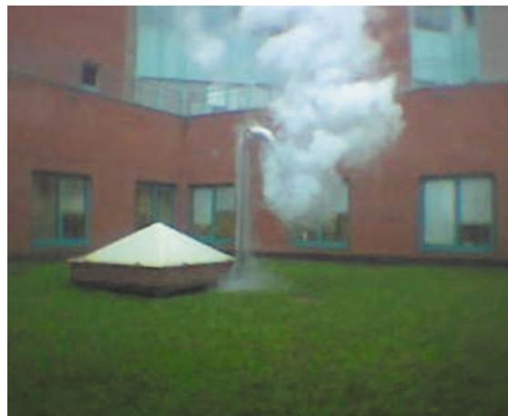
*Fotografie dell'espulsione dell'elio gassoso attraverso il condotto di sicurezza, eseguite con un cellulare subito dopo l'evento.*
