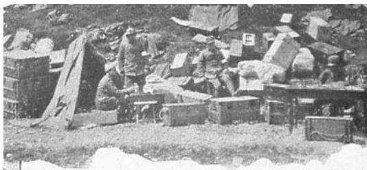
Foto 4 - Si prepara l'Ospedale da campo con le casse radiologiche
